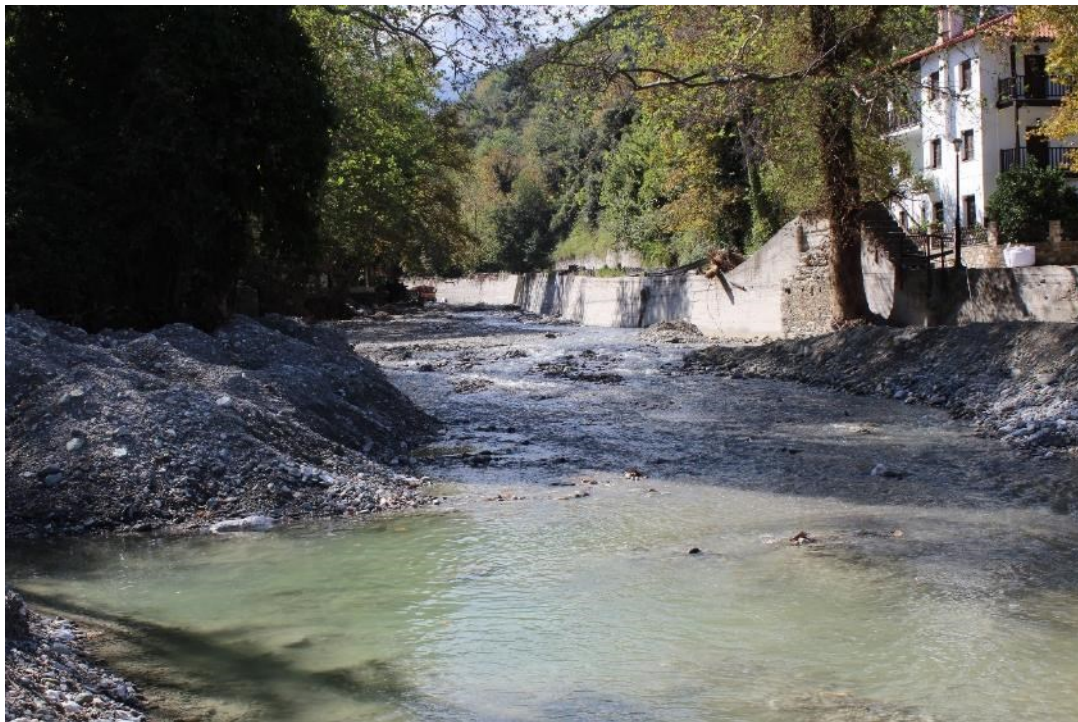
Φερτά υλικά στην κοίτη του ρέματος στο σημείο της εκβολής.
