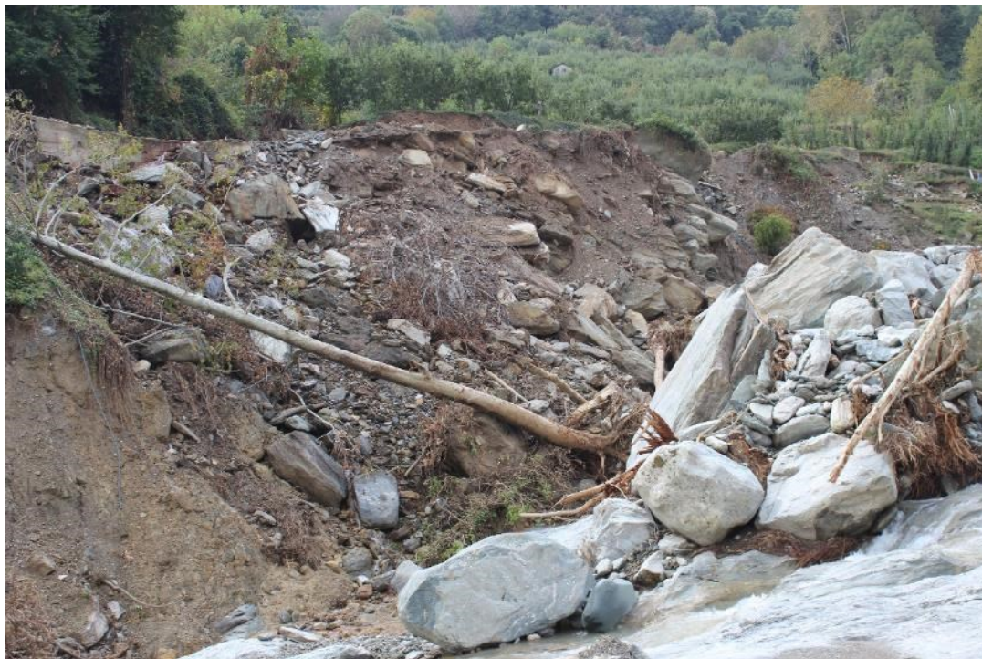
Κατολισθήσεις και φερτά υλική στην κοίτη του Γαλανορέματος.
