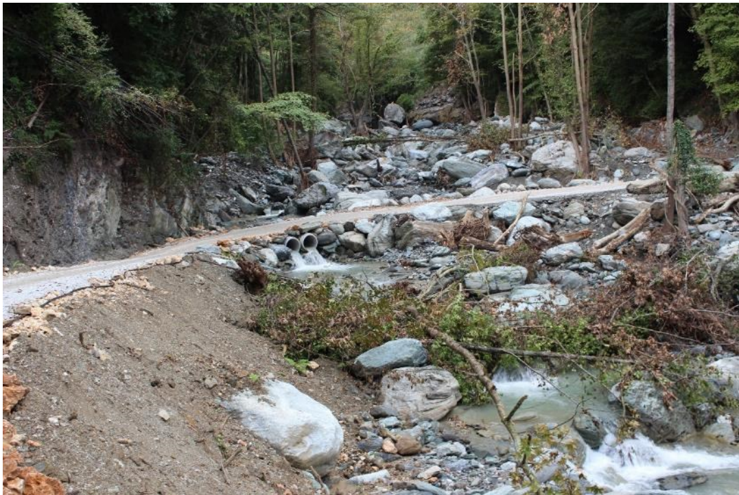
Φερτά υλικά στην κοίτη του ρέματος και ο νέος πρόχειρος δρόμος που έγινε για την διάβασή του.
